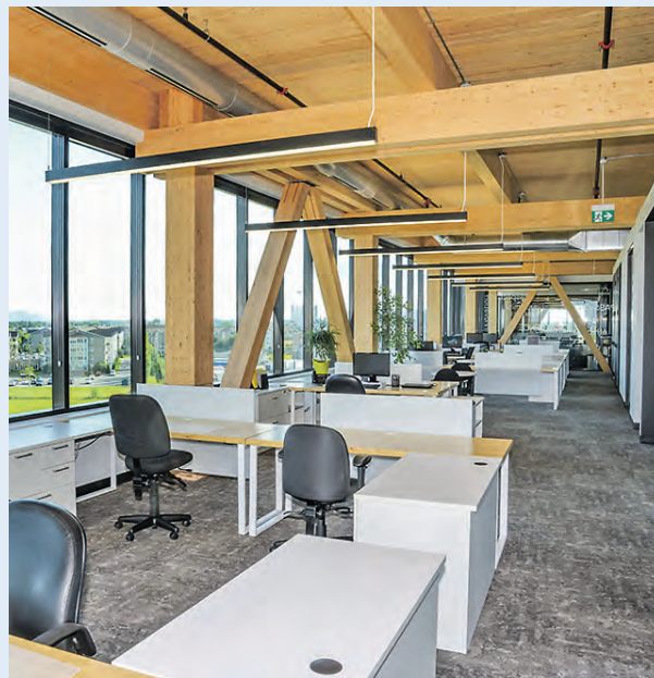
L'immeuble Synergia, à Saint-Hyacinthe, est doté d'une structure apparente qui met en valeur différentes essences de bois d'épinette, de pin et de sapin.
