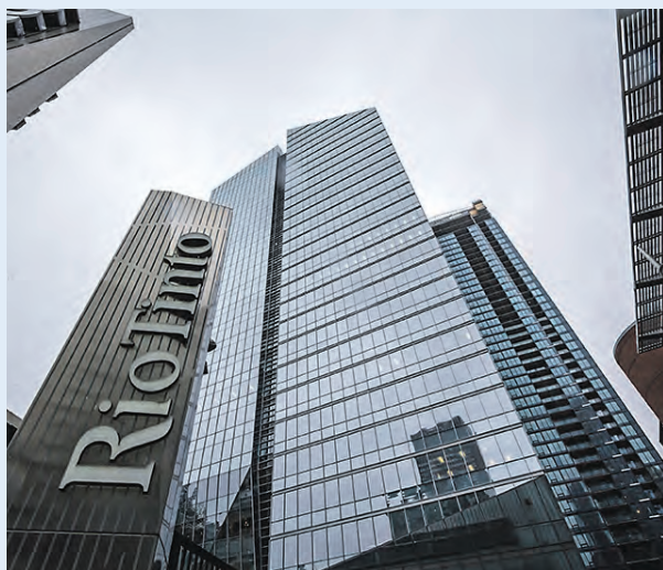
Rio Tinto a mené une étude pour voir si ses nouveaux bureaux répondaient aux besoins des employés.
